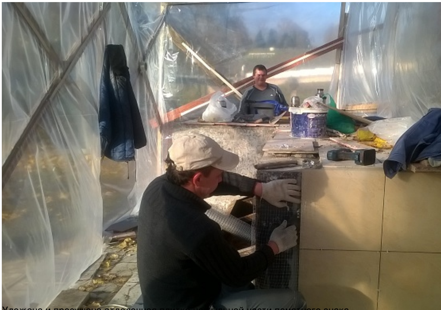
Уложена и просушена отделочная плитка на тыльной части памятного знака.
